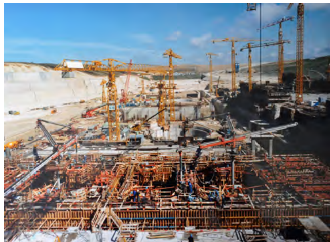
Coffrage, ferrailage et bétonnage dans une forêt de grues à tour
