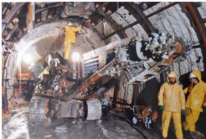
L'excavatrice en plein travail
