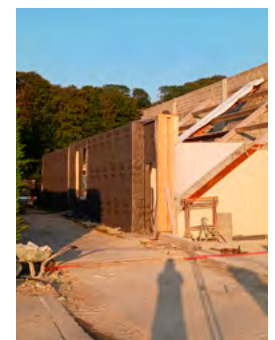
Pose des charpentes métalliques, des voliges de bois qui supporteront la toiture en zinc laqué blanc, ouverture sur la Durdent, pose d'ossatures bois
