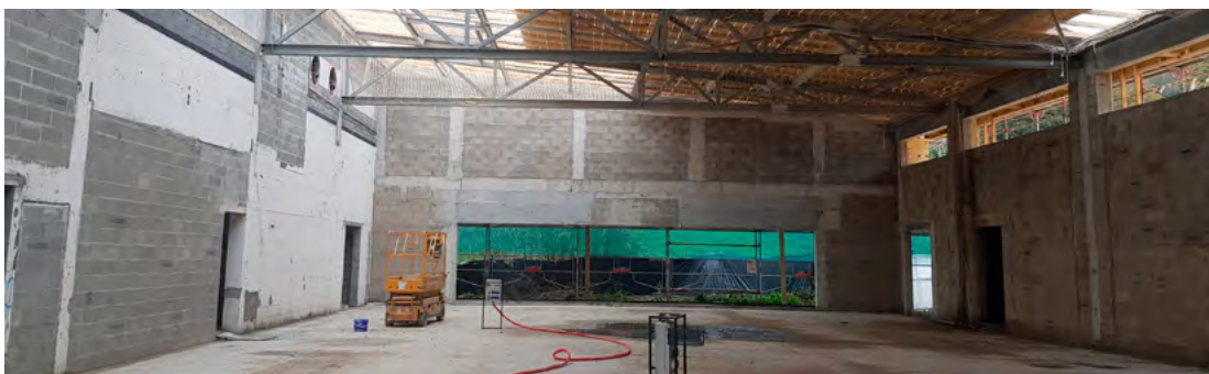
Pose des charpentes métalliques, des voliges de bois qui supporteront la toiture en zinc laqué blanc, ouverture sur la Durdent, pose d'ossatures bois
