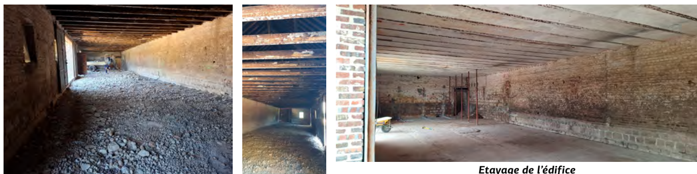
Démolition de l'ensemble de l'intérieur, évacuation des gravats et des poutrelles endommagées
